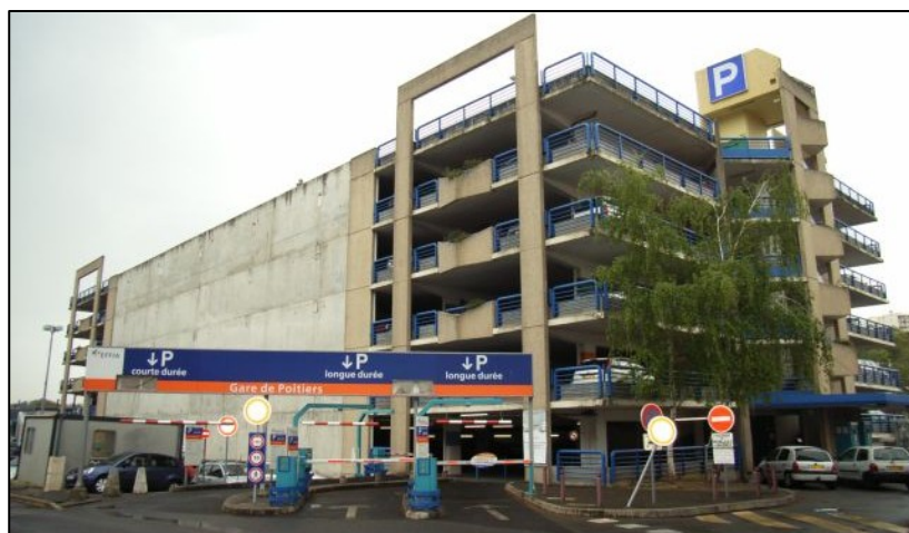
Ci-contre à gauche, puis ci-dessous, de gauche à droite : parcs payants Effia avec entrée séparée pour le stationnement courte durée (à gauche) et longue durée (à droite) ; l'aire de dépose-reprise, le parc de stationnement situé à proximité du parvis.
