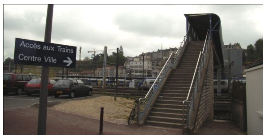
Accès piéton au centre-ville depuis la rive Ouest de la Boivre via la passerelle surplombant les quais.
