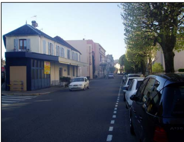
Avenue Jean Jaurès vers le sud et le pont Valentré
