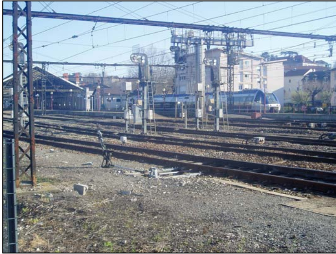
La gare et le faisceau Sud des voies
