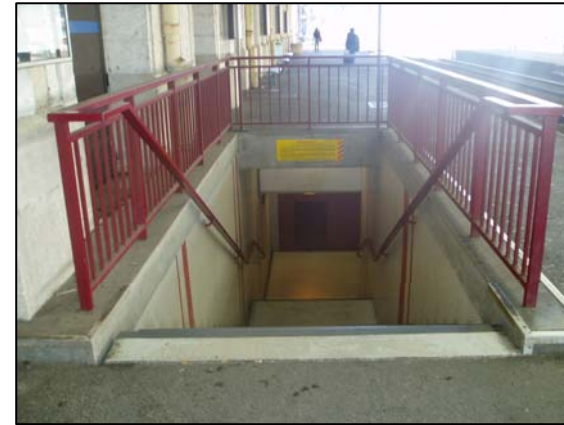
Accès au passage souterrain quai 1.
