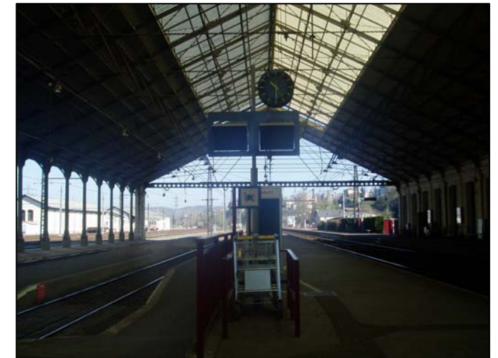
Moniteurs + horloge au débouché du passage souterrain sur le quai 2
