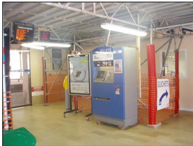
Aile droite – espace de vente en travaux
