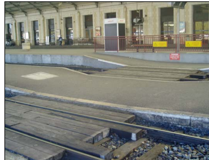
Passage à niveau entre les quais 2 – 3 et 4
