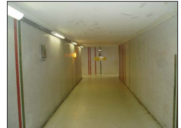
Le passage souterrain vers l'accès au quai 2.
