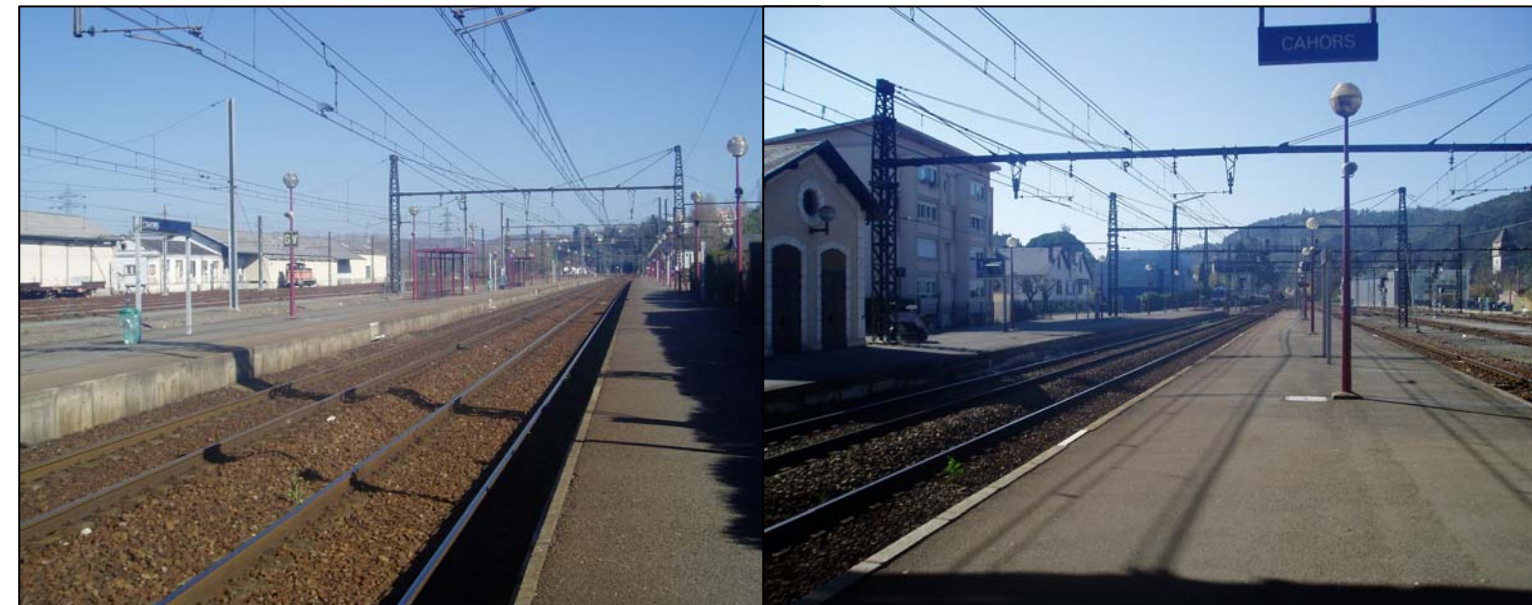
Partie Nord découverte des quais 1 et 2 avec les abris voyageurs
