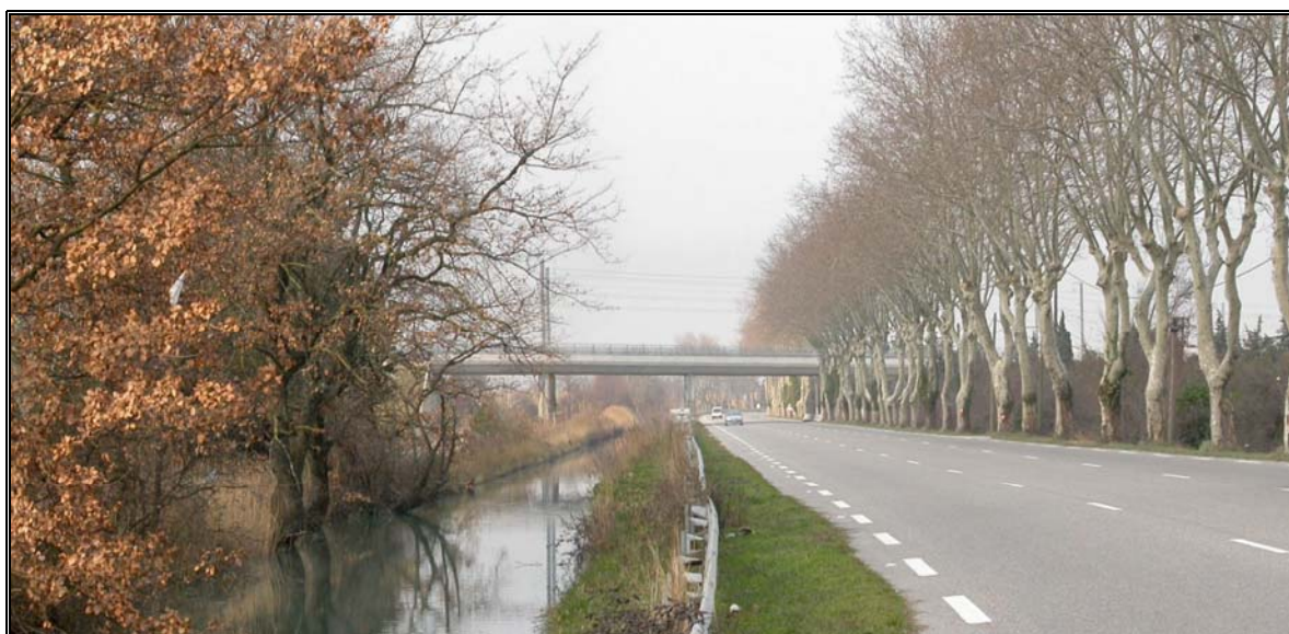
Franchissement du Canal des Alpilles et de la RN7 à Mallemort
