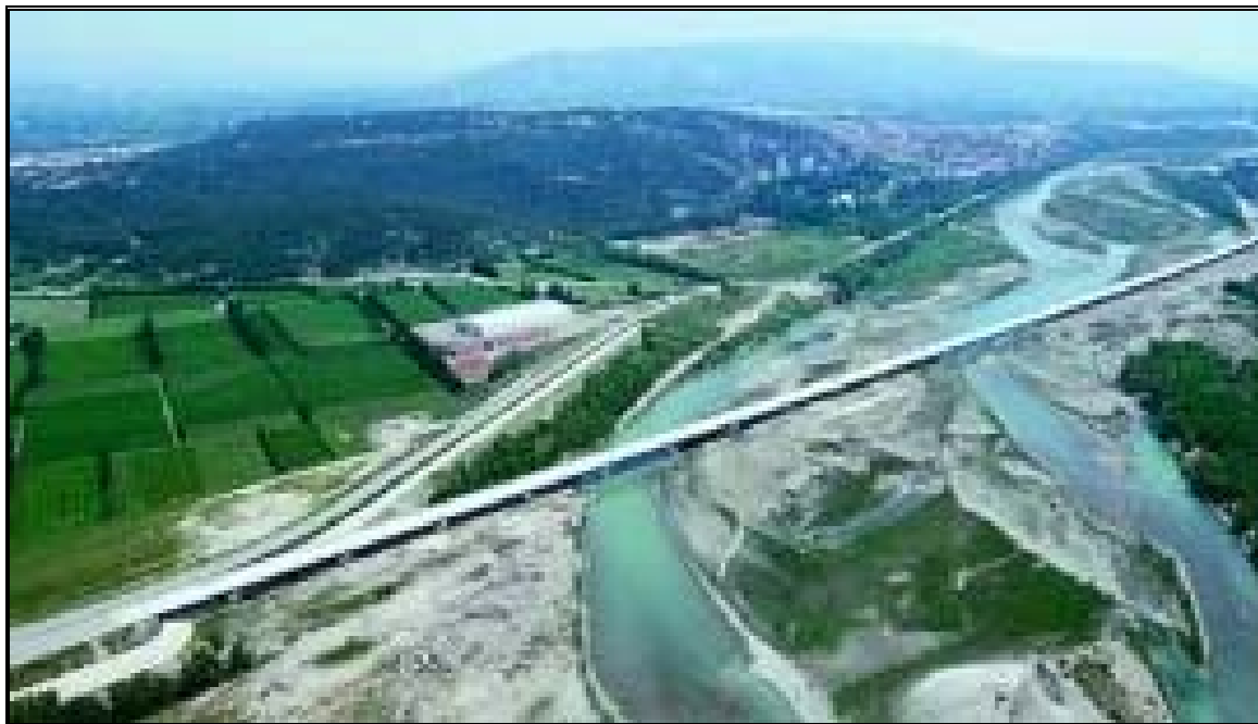
Traversée de la vallée de la Durance à Cavillon
