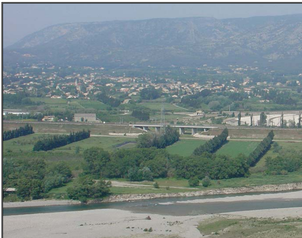
Ouvrage de décharge sur la LGV Méditerranée
