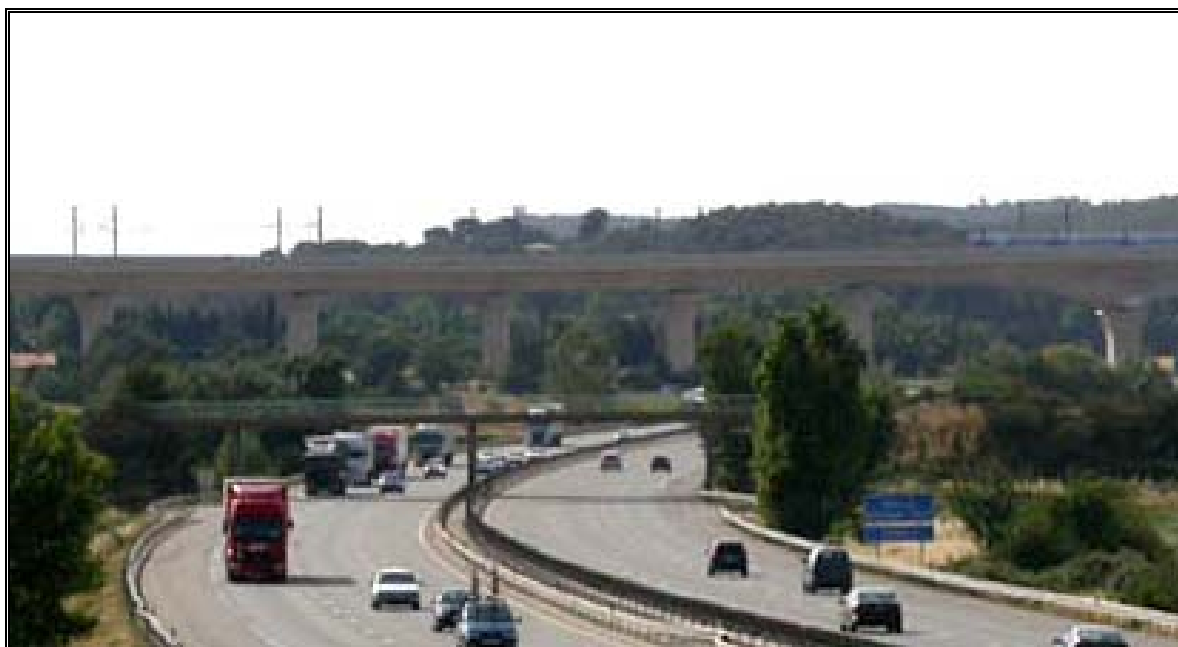
Franchissement de l'autoroute A8 à Ventabren
