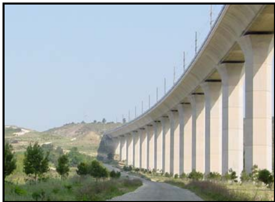
Viaduc ed Ventabren
