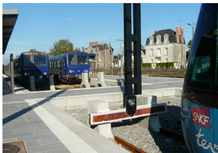
En gare de Châteaubriant, terminus du TER Pays de la Loire et en face terminus du TER Bretagne. En 2014, lors des derniers aménagements, la voie a été coupée alors que l'on parle du rapprochement des deux métropoles régionales !
