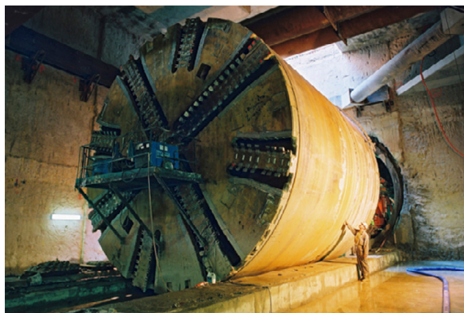
Traversée station Palais de Justice
