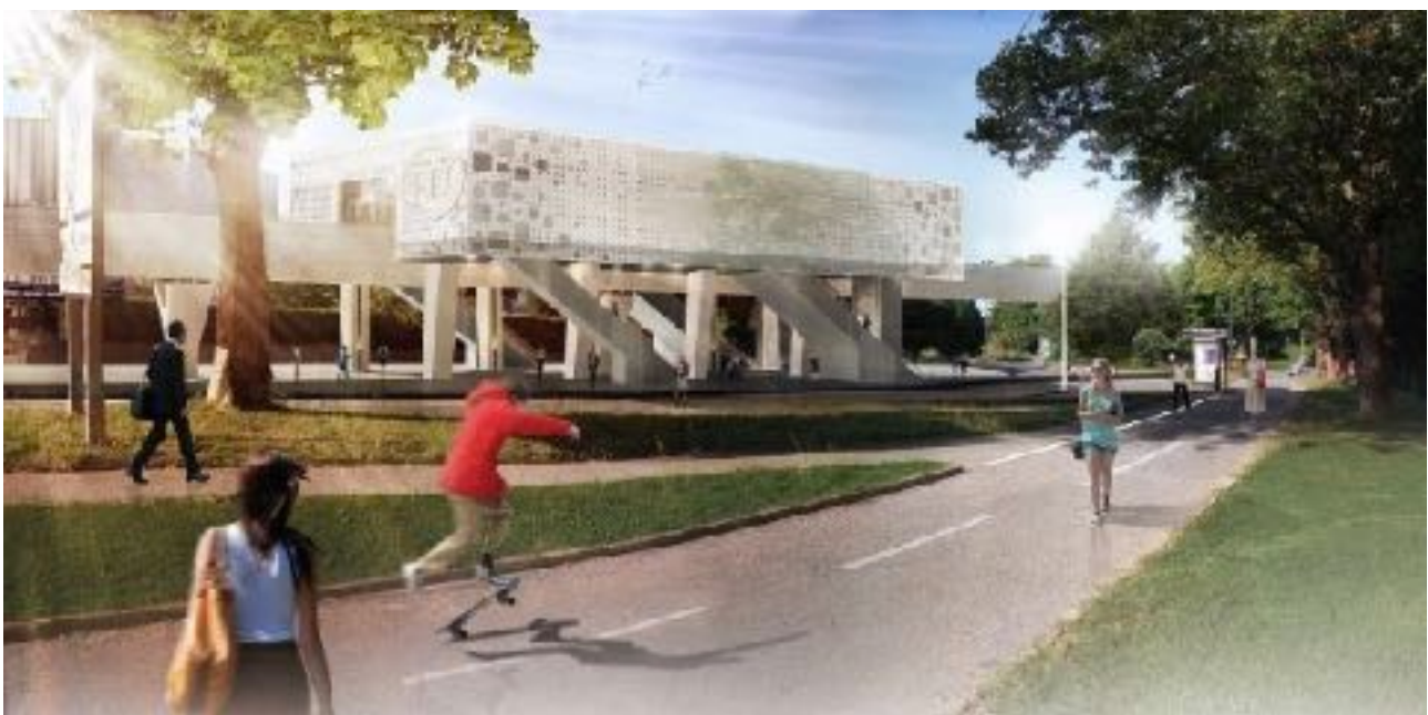
Exemple de station aérienne - Station Atalante, Métro ligne B de Rennes
