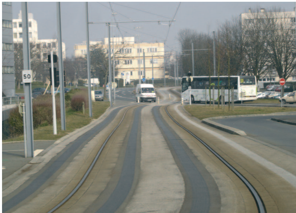
■ Figure 7 : L'orniérage de la plate-forme du TVR de Caen (vu ici à la Pierre Heuzé) nécessite des travaux réguliers de rechargement, que trahit ici la différence de couleur du revêtement (photo Pierre Zembri).
