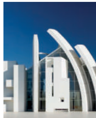
L'église du Jubilé à Rome (photo), comme la cité des Beaux-Arts de Chambéry, sont des exemples d'utilisation d'un béton non salissant intégrant des nanoparticules de dioxyde de titane.
