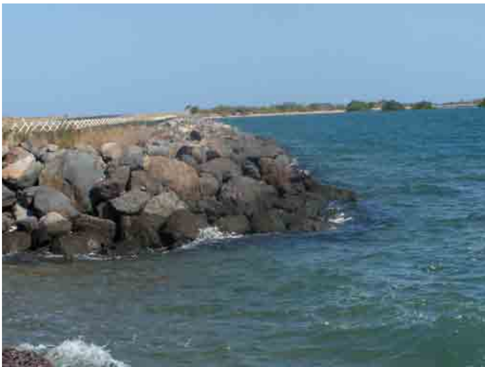
Photo 2 : Section de type 4 : enrochements naturels actuels (nord-ouest piste)
