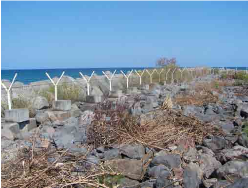
Photo 1 : Section de type 1: blocs en béton et enrochements naturels actuels (sud-est piste)
