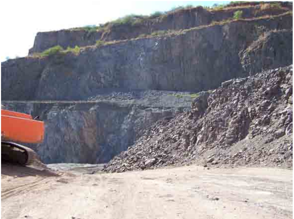
Photo 5 : Front de taille de la carrière ETPC de Koungou
