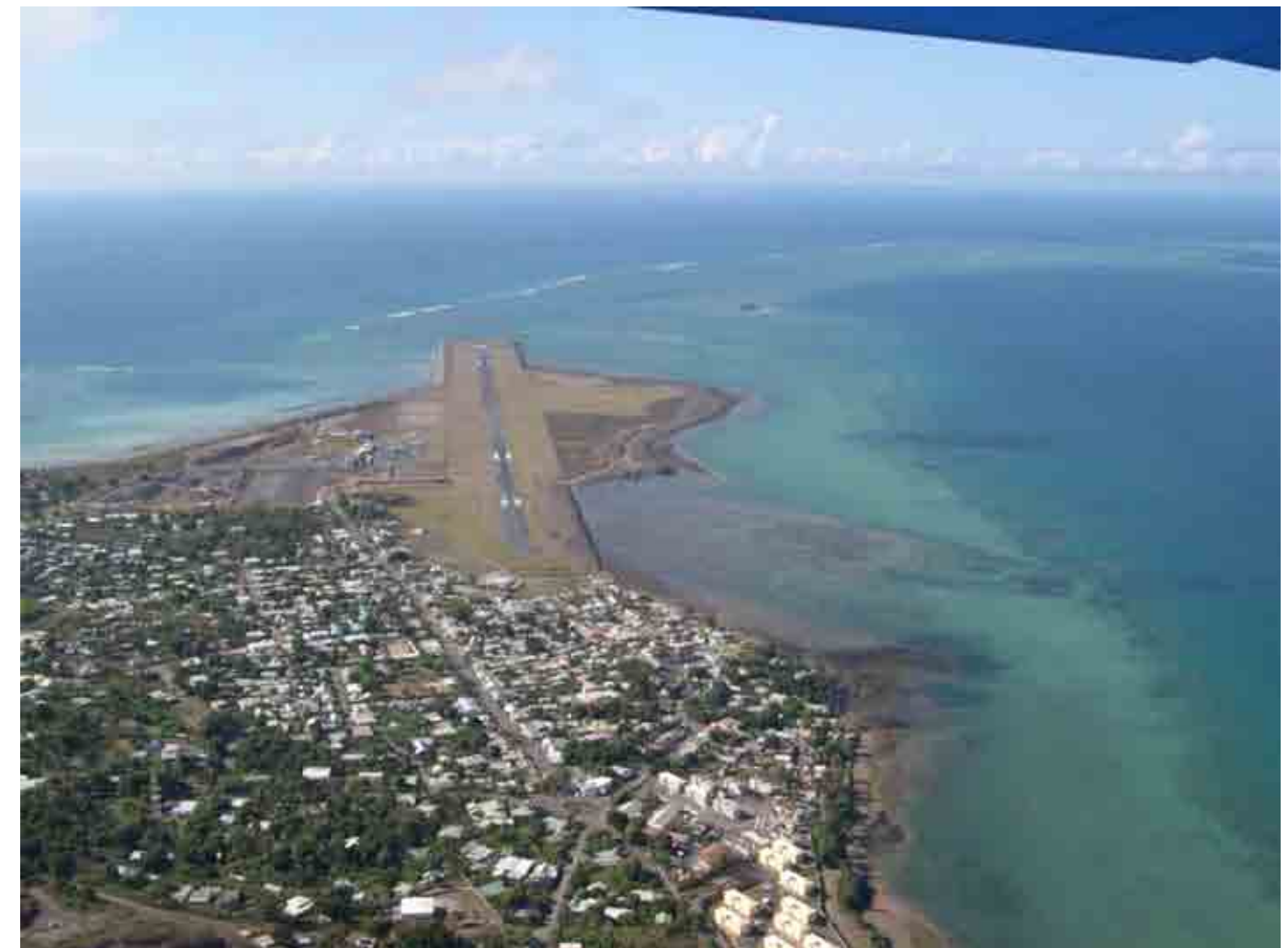
Figure 2 – Vue aérienne de la piste actuelle (côté seuil 16)
