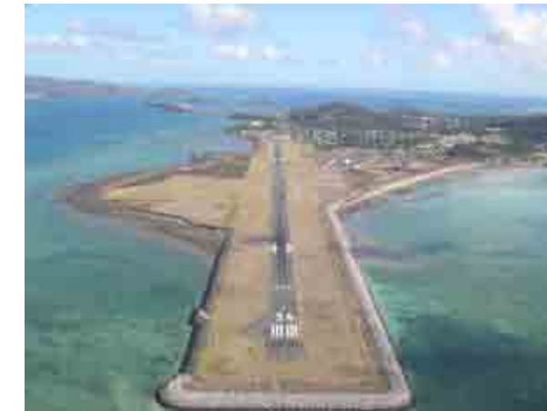
Figure 10 – Vue du seuil 34 actuel
