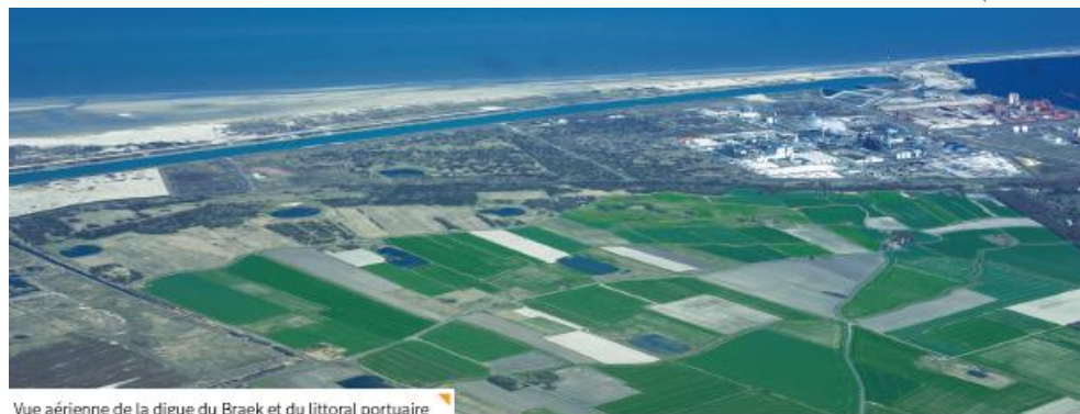
Vue aérienne de la digue du Braek et du littoral portuaire
