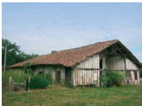
Maison à pans de bois et torchis de la Haute-Lande (source: PNRLG)
