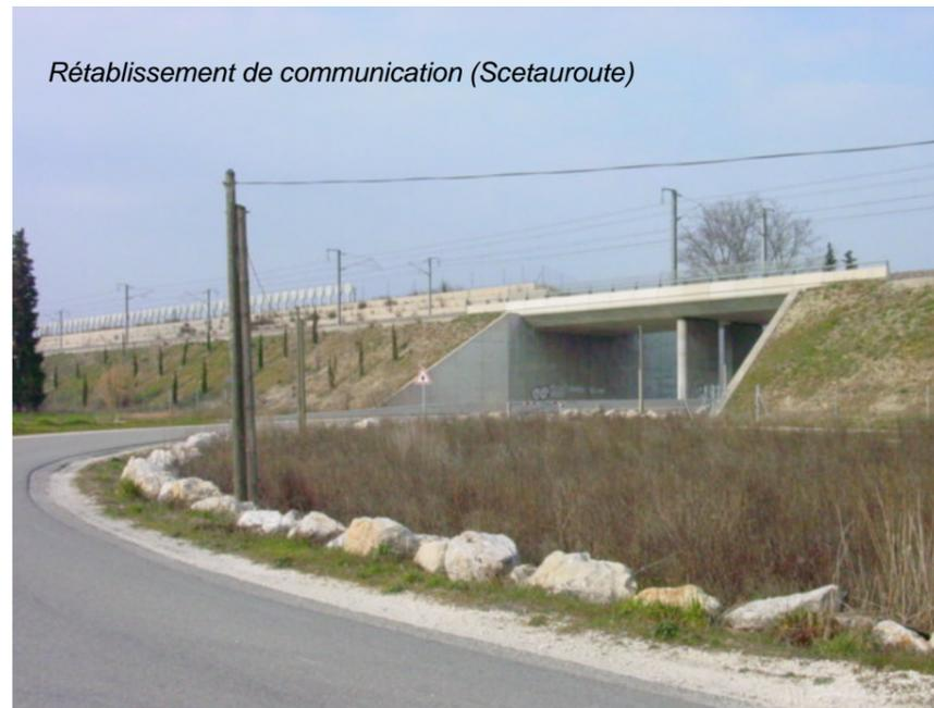
*Le rétablissement des communications peut ainsi passer par la création de voies de desserte complémentaires parallèlement à la nouvelle infrastructure associée à la réalisation d'ouvrages de franchissement de la ligne, ainsi que représenté ci-contre.*
