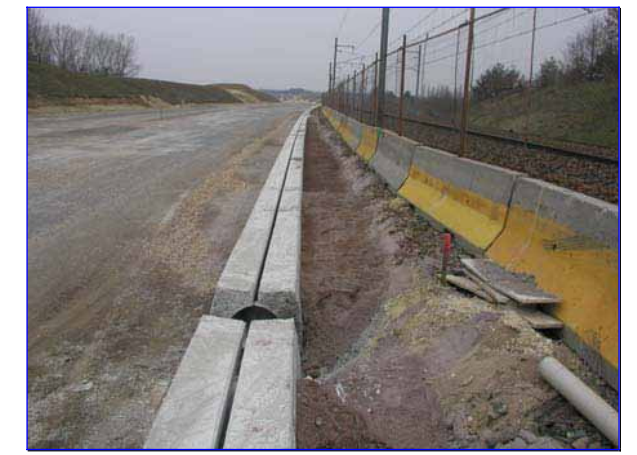
Installation de barrières provisoires
