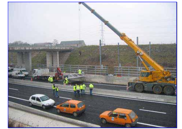
Présence de personnel de sécurité
