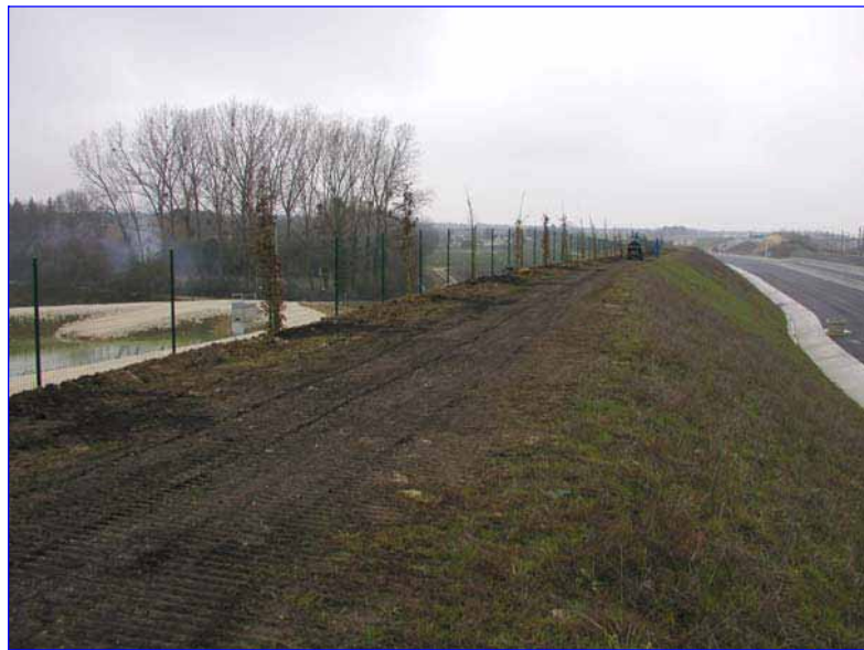
Contournement de Tours - mise en place d'une haie paysagère
