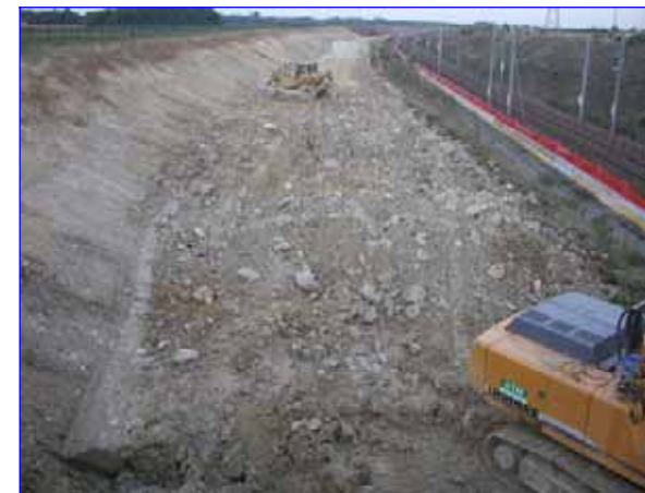
Modalités de terrassement : décaissement par paliers
