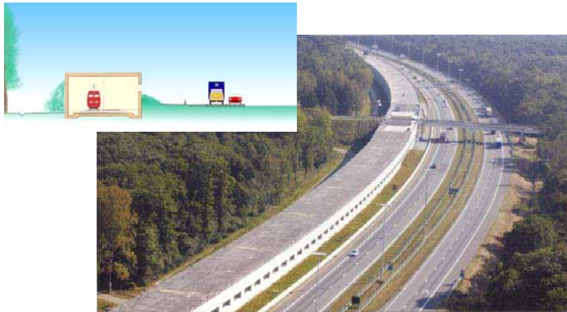
LGV en tunnel pour le passage le long d'un bois sur la liaison Anvers-Breda Source : TUCRAIL
