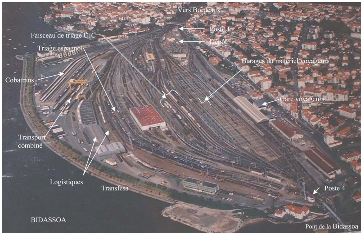
Figure 14 : Vue aérienne du complexe ferroviaire d'Hendaye
