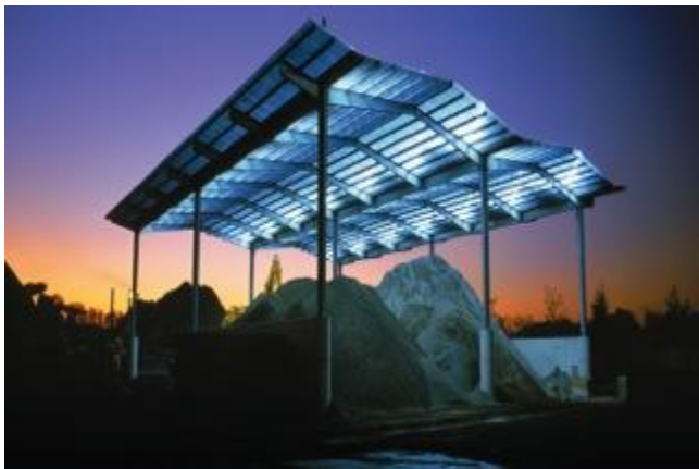
Valorisation , recyclage des des produits de chantier...
