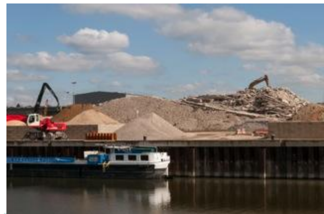
Valorisation, recyclage des des produits de chantier...
