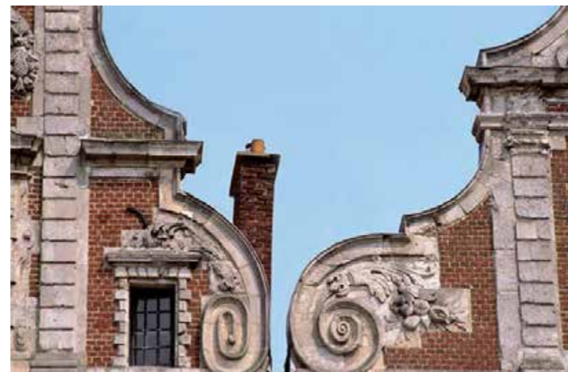
Arras - Place. Détails architecture
