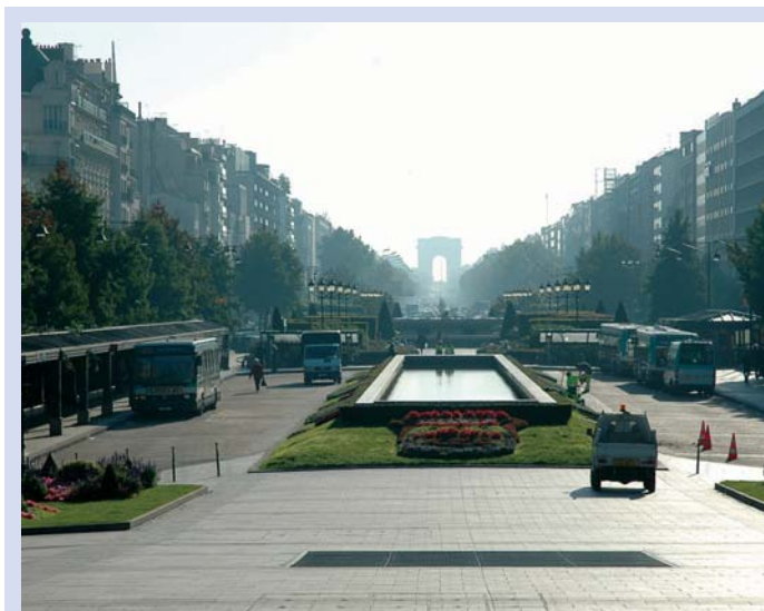
La partie de l'avenue déjà couverte, entre le carrefour Madrid et le pont de Neuilly.
