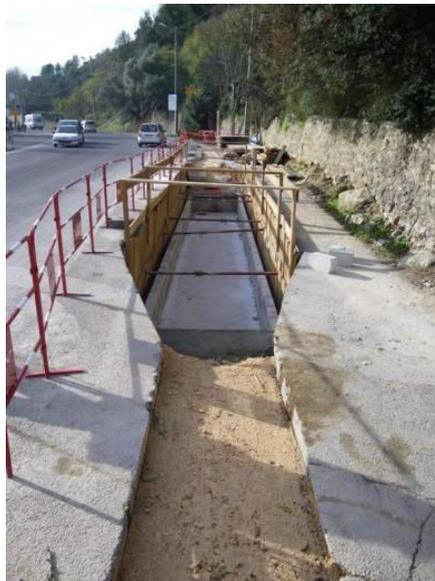
**Exemple d'une chambre de jonction pour un circuit à 225 000 volts**
