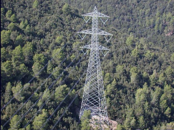
← Les supports: essentiellement constitués de charpentes métalliques boulonnées.
