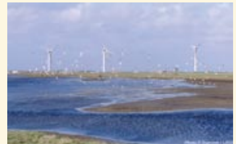
Site éolien de Bouin
