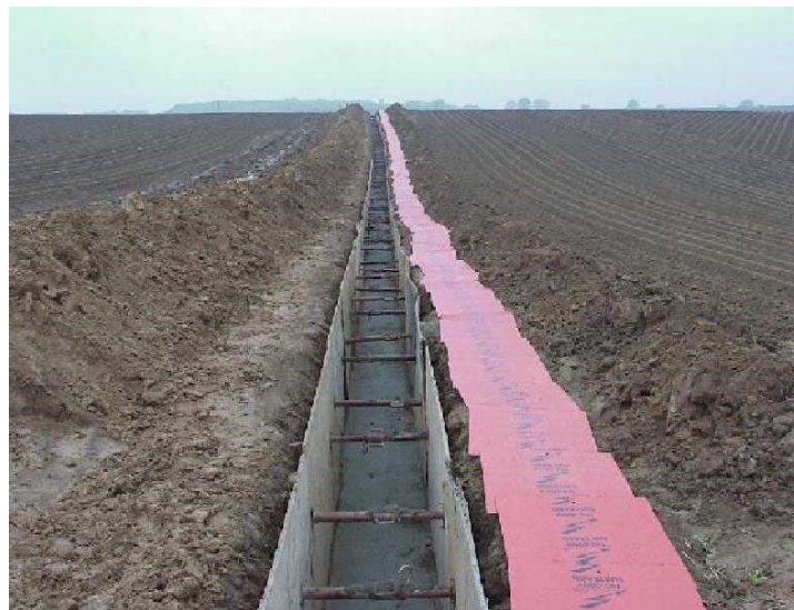
Figure 3-44: exemple de tranchée pour câbles enterrés directement
