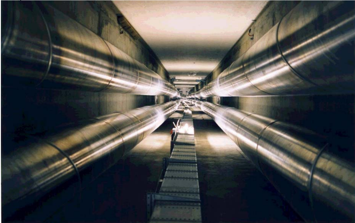
Figure 3-67: tunnel contenant les câbles à isolation gazeuse à Genève
