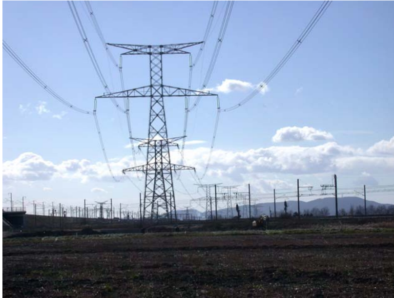
Figure 3-3: Exemple de support d'une ligne de 225 kV double terre
