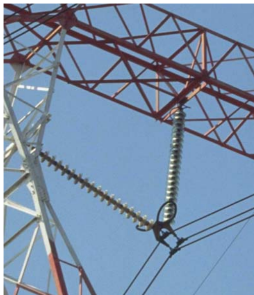
Figure 3-14: Vue d'un groupe de suspension d'une ligne 400 kV
