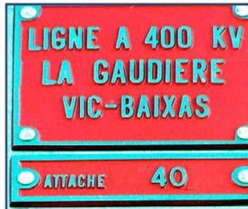
Figure 3-16: Vue d'un panneau indicateur d'installation
