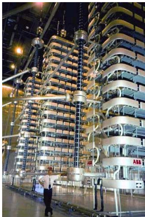
Figure 3-81: convertisseur en pont dodécaphasé dans un poste HVDC
