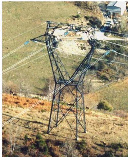
Figure 3-30: support pour ligne à simple terre de type T-A
