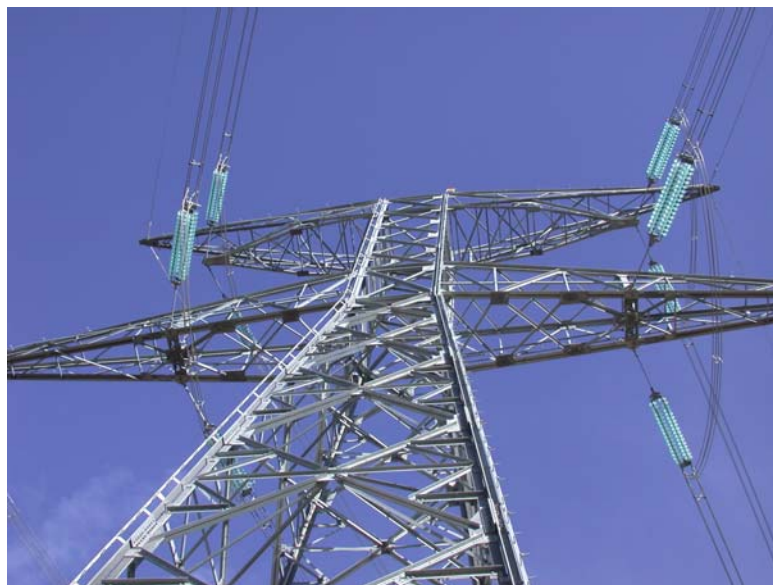
Figure 3-4: Vue du support d'une ligne à 220 kV double terre
