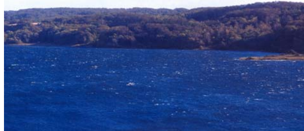
Figure 3-64 : Dépose de la ligne aérienne 150 kV existante au travers du Fjord Mariager
