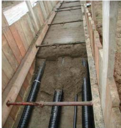
Figure 6-8 : Aspect d'un chantier pour la pose d'un simple circuit 400 kV
