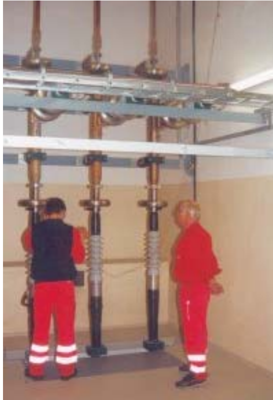
Figure 3-98: bornes terminales des câbles de distribution SHT installés au Danemark
