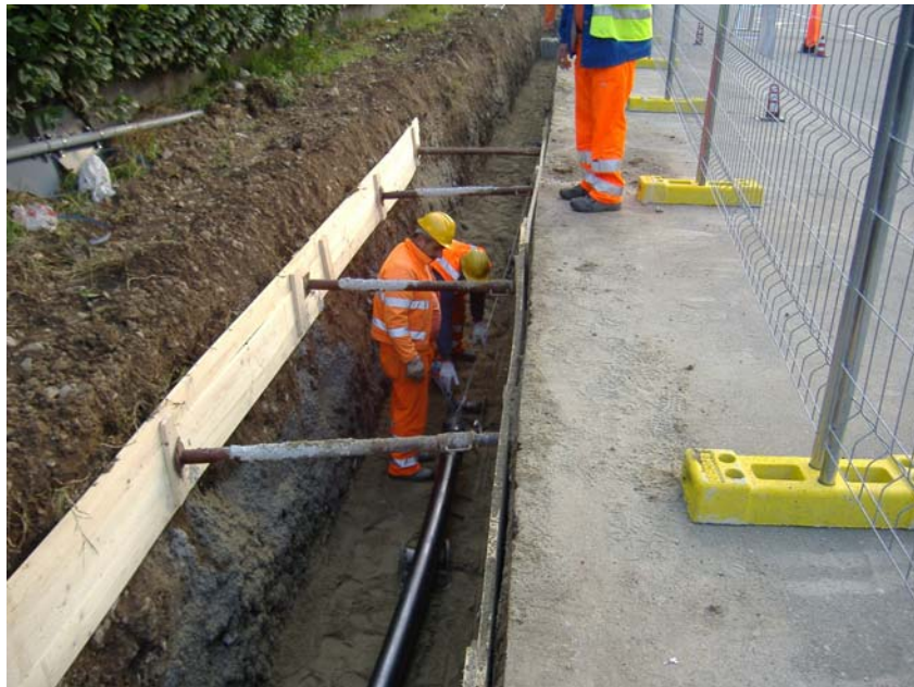
Figure 3-45 : pose d'un câble 400 kV en Italie le long d'une route départementale
