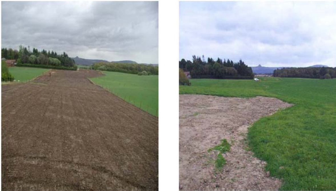
Figure 6-9 : pose d’un câble 400 kV (4 tri –câbles) dans la campagne anglaise. Aspect à la fin de la pose et 8 mois après la fin du chantier
