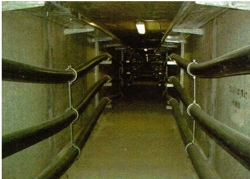
Figure 3-35 : tunnel de la connexion en câbles de Madrid
