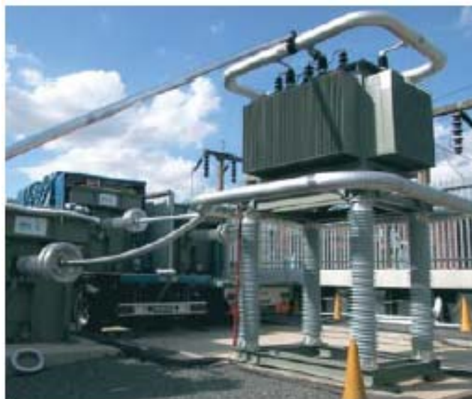
Figure 3-36 : essai de mise en service du câble du projet ELSTREE
