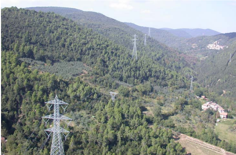
Figure 3-1: Exemple de ligne double terre 400 kV italienne en montagne
