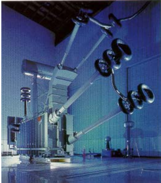
Figure 3-79: exemple de transformateur de conversion
