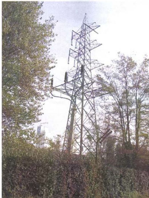
Figure 3-65 : extrémités de câble accrochées à un poteau de ligne aérienne HT à 130 kV
