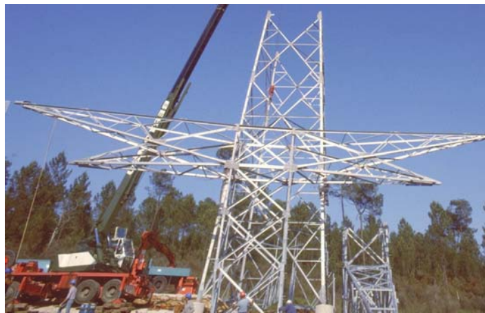
Figure 3-17: Vue du montage d'un support avec l'aide d'une grue
