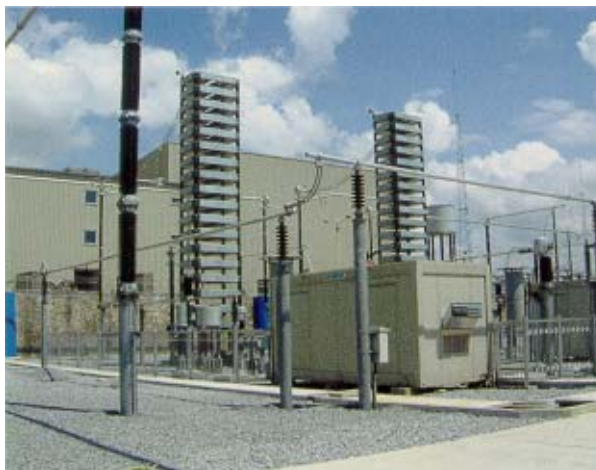
Figure 3-84: Filtre c.c. actif de 200kVA
