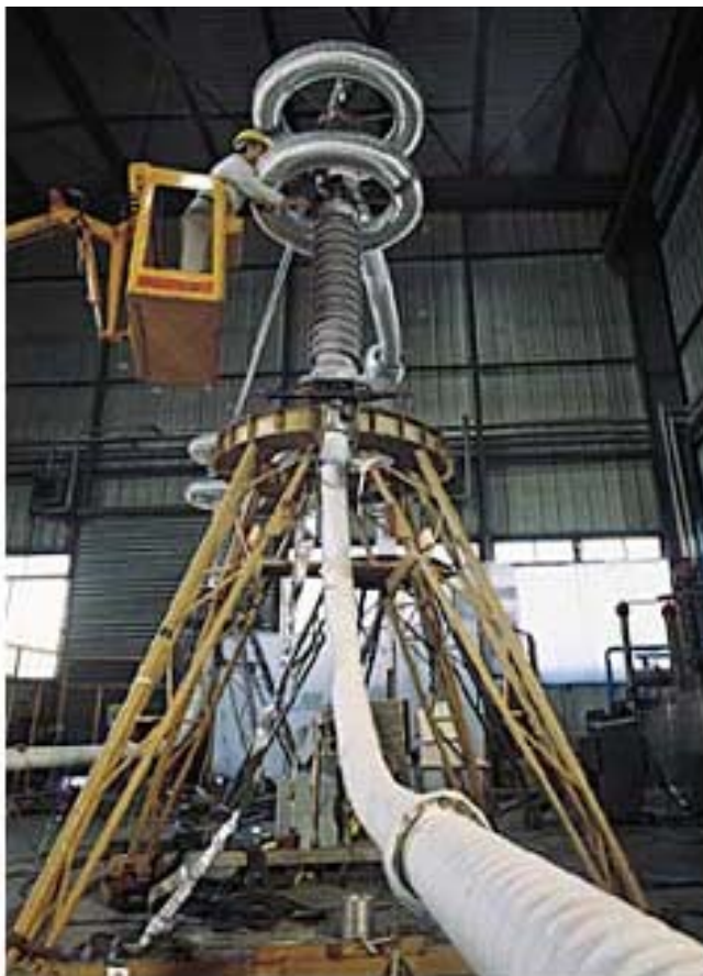
Figure 3-96: Borne terminale du câble Pirelli 115 kV en phase d'essais
