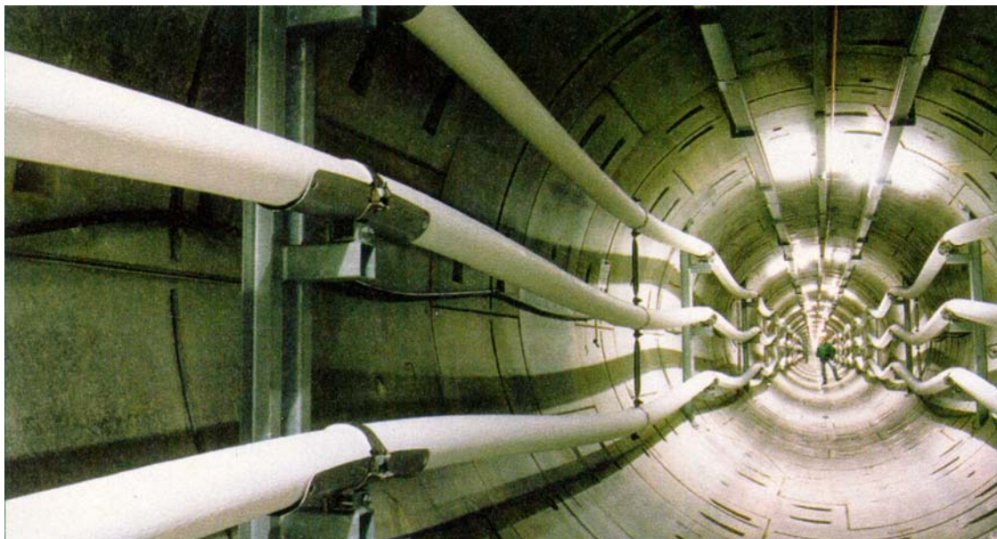
Figure 3-33: photographie de l'installation en tunnel avec câbles accrochés
