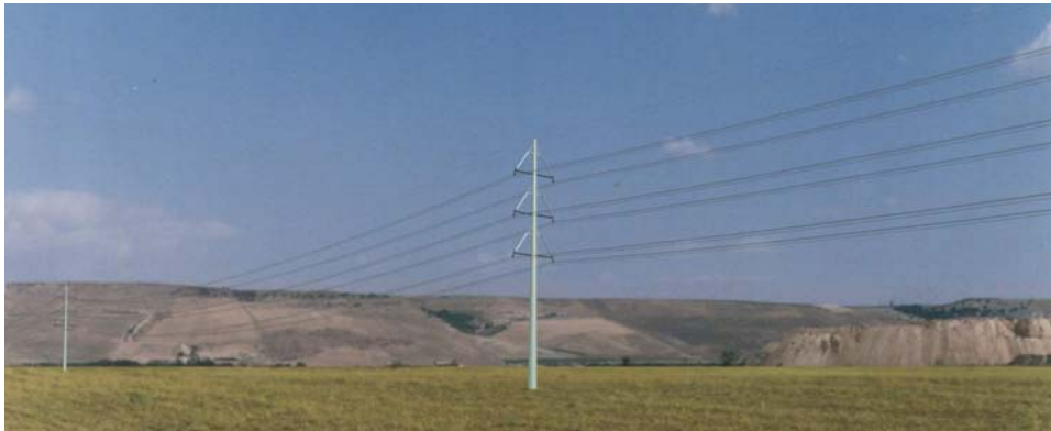
Figure 3-5: Vue d'un support d'une ligne de 400 kV à tube polygonal de type à consoles isolantes (photomontage)
