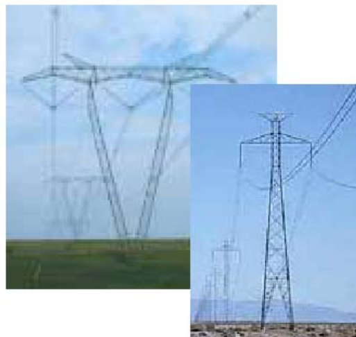
Figure 3-90 : comparaison visuelle entre une ligne THT en tension alternative et une ligne en courant continu ayant la même capacité de transport
