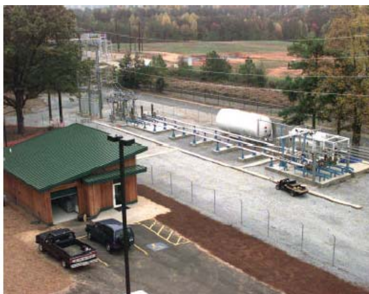
Figure 3-97: première installation mondiale d'un câble triphasé SHT dans une installation industrielle (Southwire)
