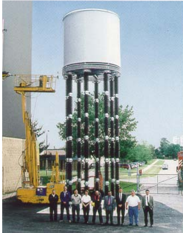
Figure 3-82: Réacteur isolé en air 150mH, 500kV, 1800 A
