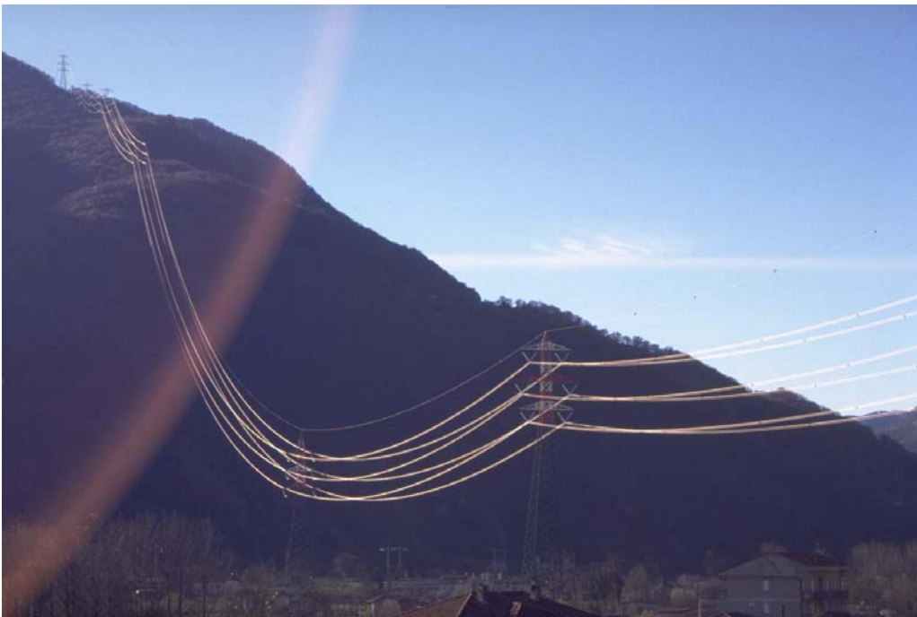
Figure 3-2: Vue des faisceaux de conducteurs d'une ligne à 400 kV double terne italienne
