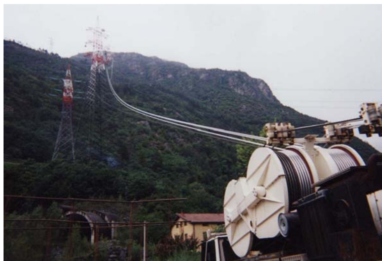
Figure 3-18: Installation d'un faisceau de conducteurs sur une ligne de 400 kV
