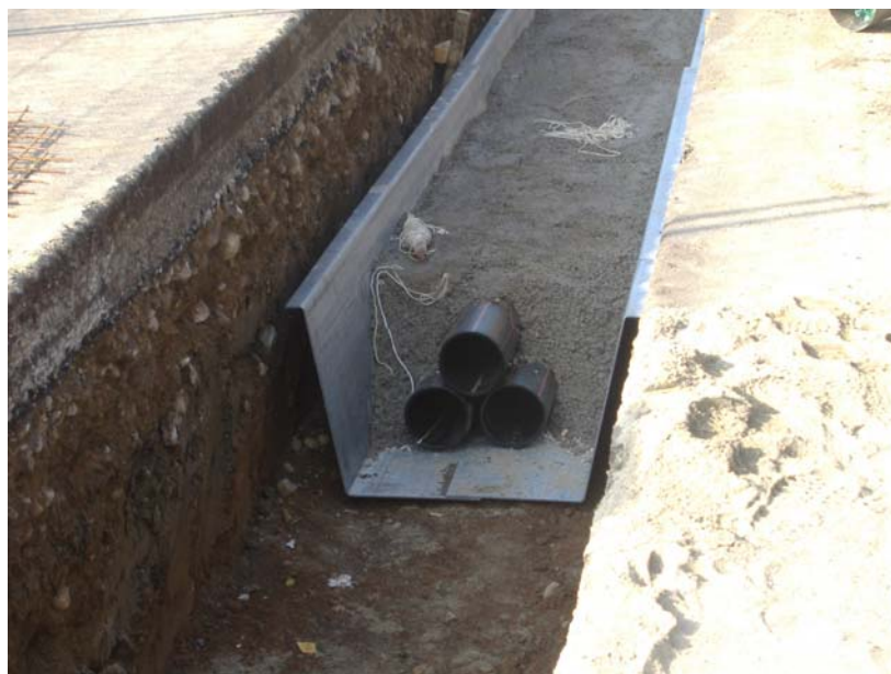
Figure 3-52 : pose de câble THT en Italie et utilisation d'écran magnétique à l'approche de zones urbaines
