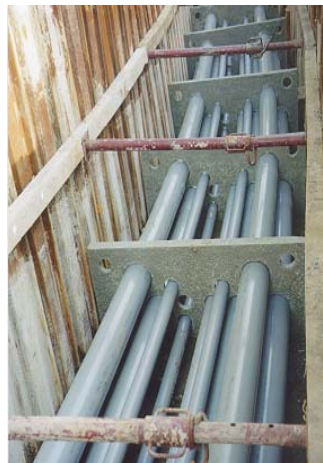
Figure 3-50: exemple de pose en tubes d'un double terna de câbles
