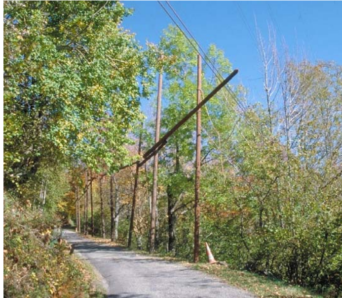
Figure 3-21: Installation des conducteurs: structures provisoires de protection des oeuvres traversées
