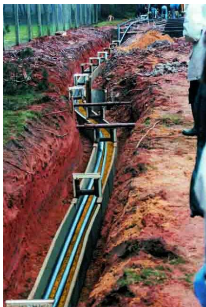
Figure 3-46: câbles posés en fourreau enterré
