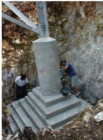
Figure 3-6: Vue d'une fondation d'une ligne 400 kV
