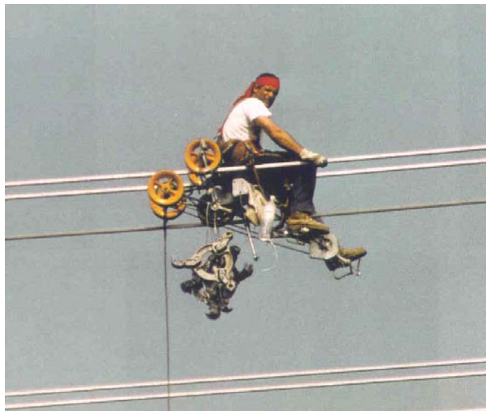
Figure 3-20: Installation des entretoises sur une ligne de 400 kV équipée de faisceau à trois câbles
