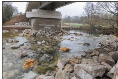
Remise en état après travaux avec amélioration du lit de la rivière
