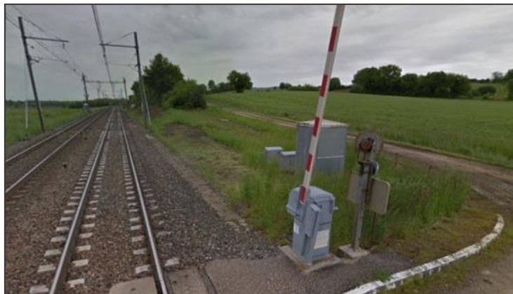
Cas d'une ligne en Bourgogne Franche-Comté au droit d'un passage à niveau – 2 voies électrifiées
