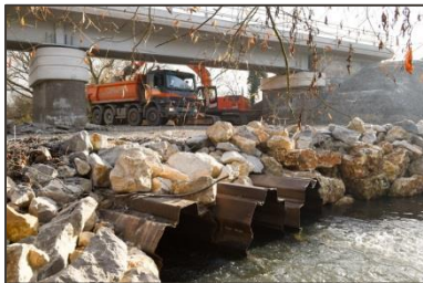
La Bourbeuse (90) pendant les travaux
