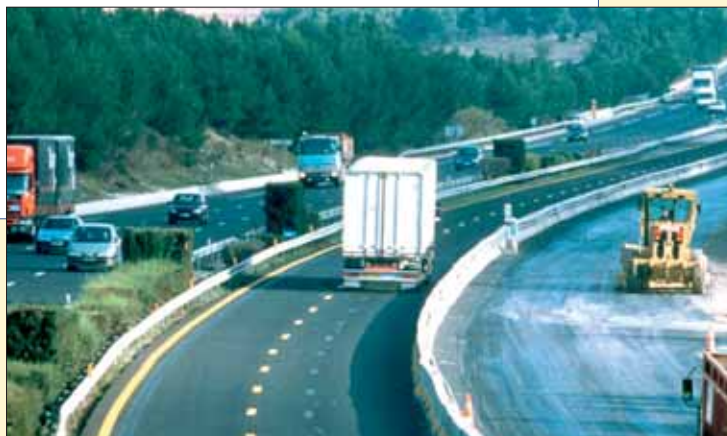
Travaux d'élargissement sur autoroute. Photo : photothèque ASF
