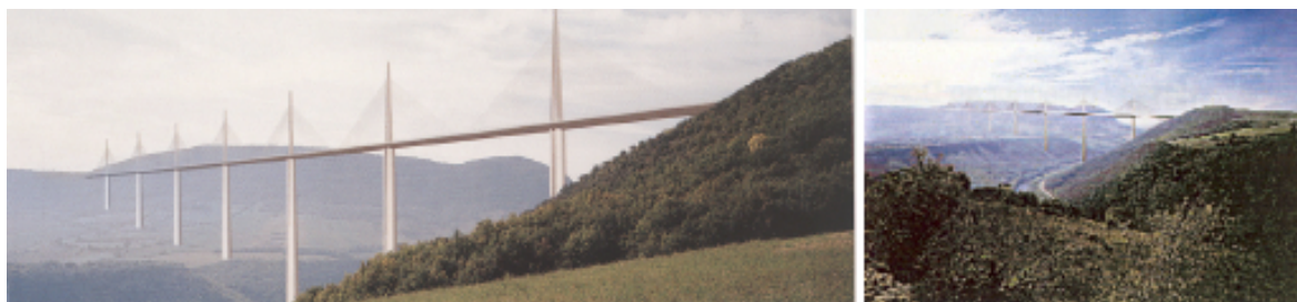
Viaduc de Millau
