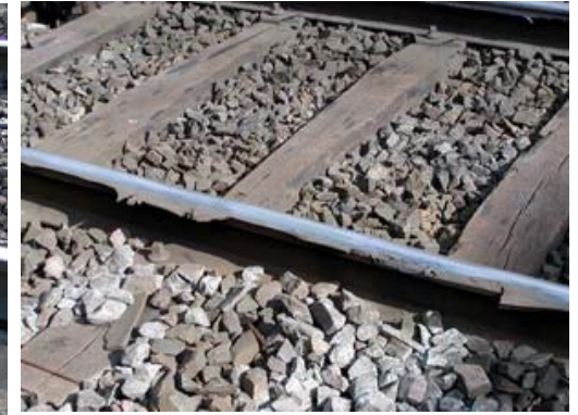
Du ballast a été rajouté, mais le coupon de rail n'a pas été changé !
