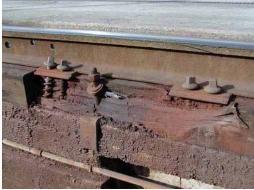
Un réseau dégradé sur les emprises SNCF (Dépôts de Chatillon et de Montrouge) à l'origine de ralentissements et d'incidents de circulation
