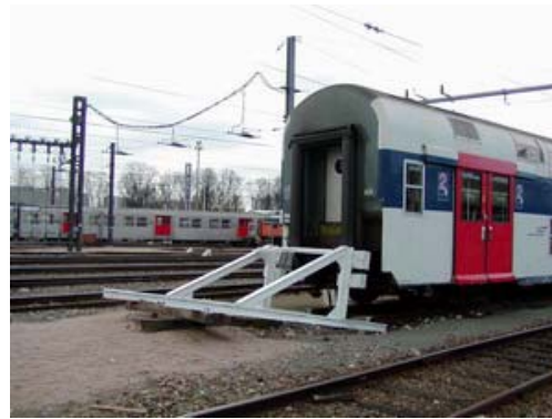
Un buttoir percuté depuis plusieurs mois !
