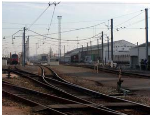
...qui pourrait servir à l'utilisation de matériel de la ligne C et de la ligne de la Défense, en particulier, en journée
