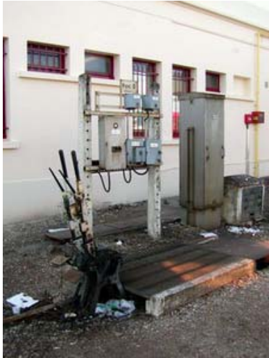
Une commande manuelle d'aiguillage à Plaisir Grignon...
