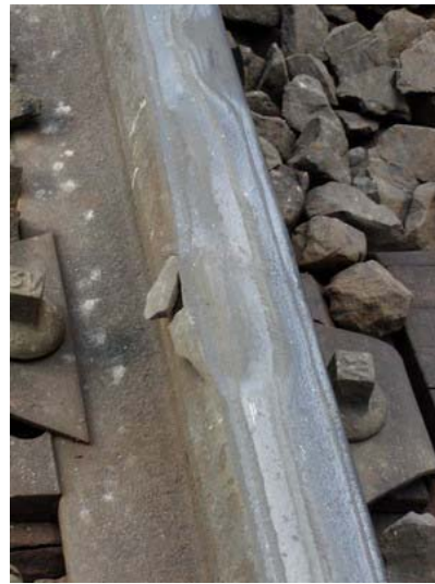
Une réparation "provisoire" sur un rail cassé en place depuis plusieurs années !
