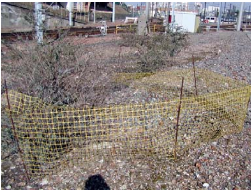
Un fontis (éboulement) délimité par des piquets à quelques mètres des voies... témoin des anciennes carrières de craie.
