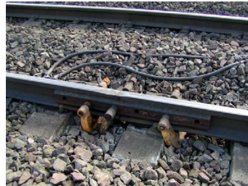
Une réparation "provisoire" sur un rail cassé en place depuis plusieurs années !
