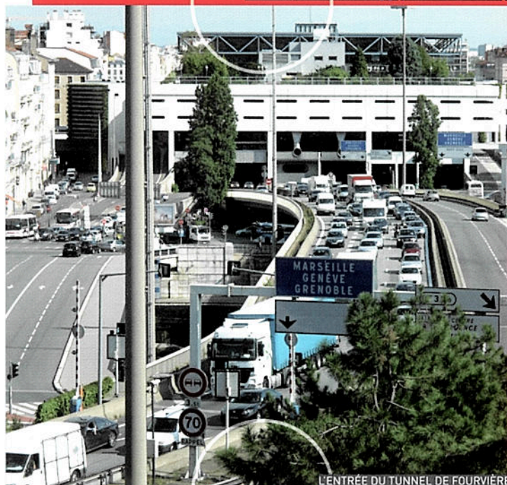
L'ENTRÉE DU TUNNEL DE FOURVIÈRE
