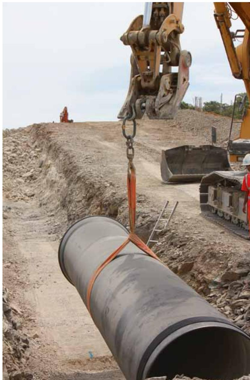
*Pose d'une canalisation en diamètre 1200mm*
