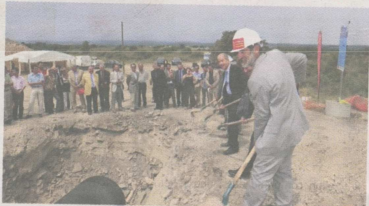
Premier « tuyau », pour 130 kilomètres de canalisations Aqua Domitia.
