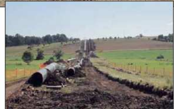
Pendant les travaux, l'emprise sera d'une vingtaine de mètres de largeur.
