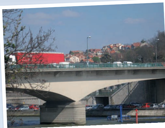
Pont de Villeneuve enjambant la Seine
