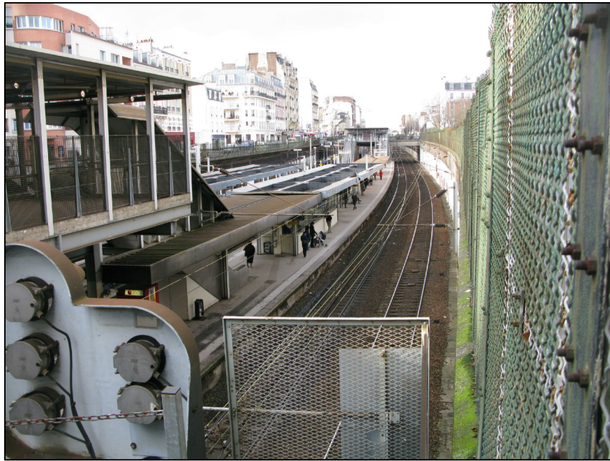
Gare de "Bois Colombes" existante, en tranchée ouverte
