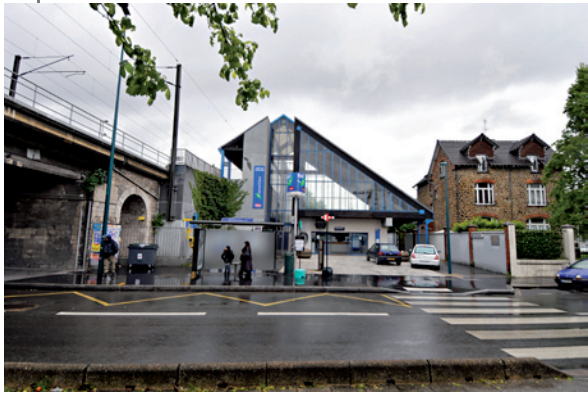
03_La gare accolée au pont ferroviaire
