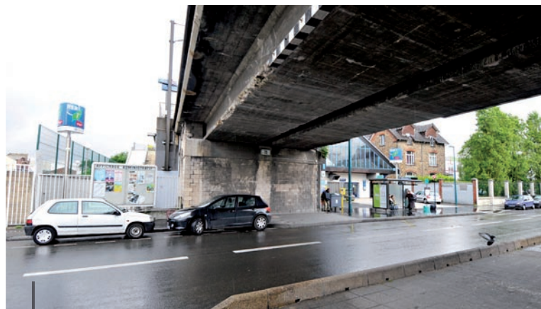
02_ Pont ferroviaire Avenue des Grésillons
