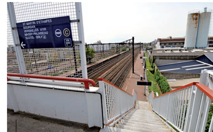
03_ Connection entre les quais
