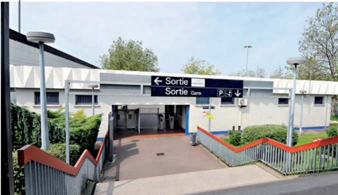
03_Accès depuis le Bâtiment Voyageurs
