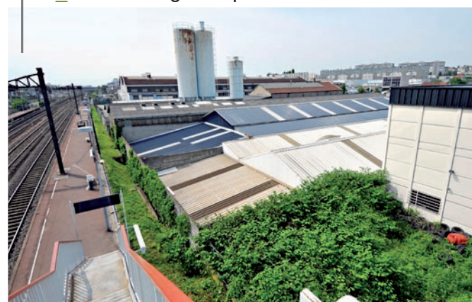
05_ Talus le long des quais
