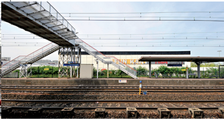
03_Escalier d'accès au quai 1
