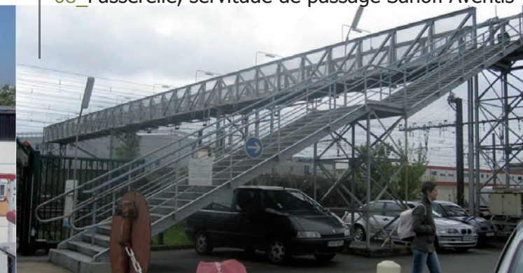
08_Passerelle, servitude de passage Sanofi Aventis
