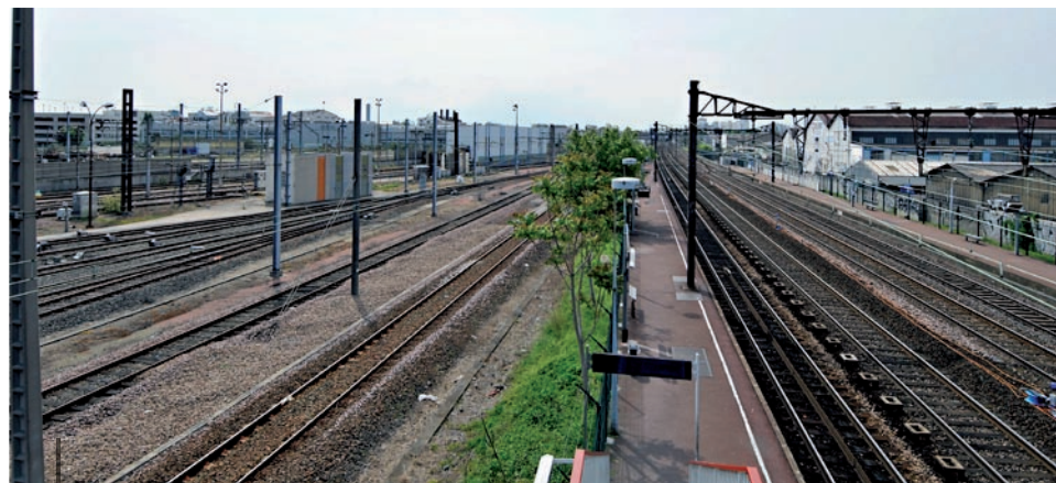
02_ Talus le long des quais
