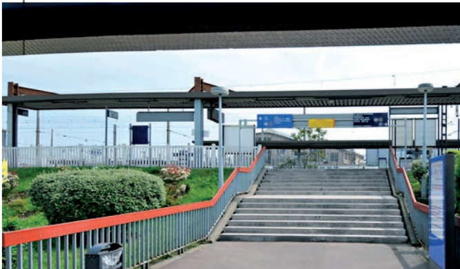
02_Accès principal aux quais
