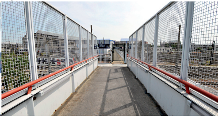
02_Passerelle piétonne d'accès aux quais
