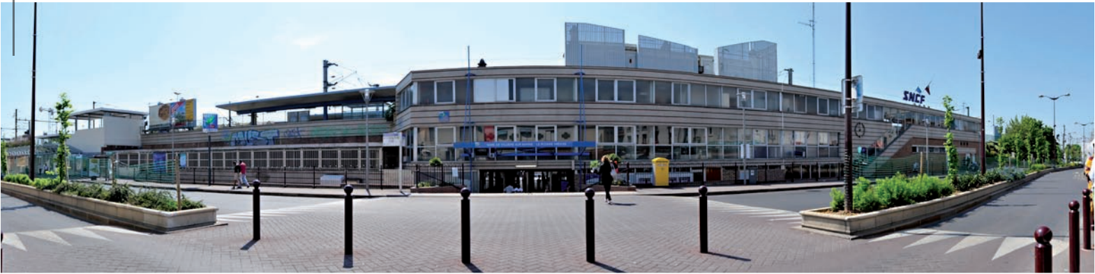
01_ Bâtiment bordant les voies vu depuis la place de Gare
