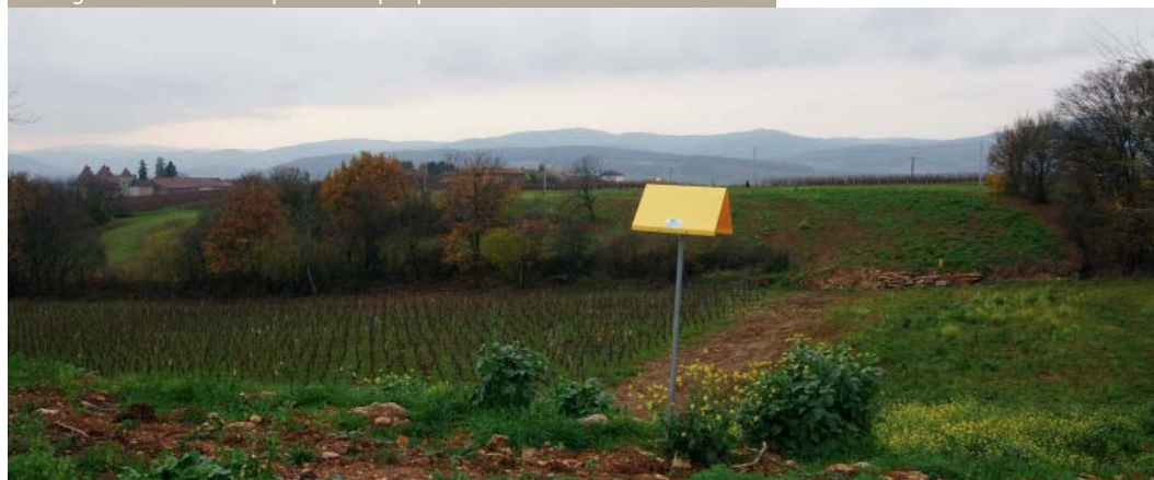
Passage de la canalisation peu de temps après remise en état
