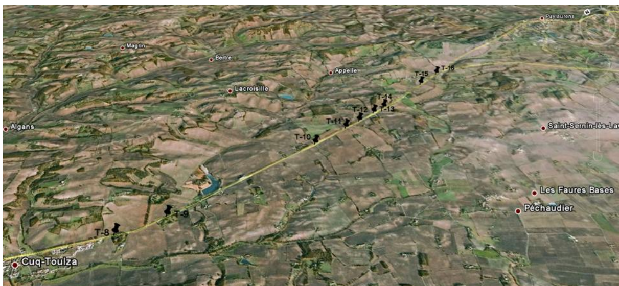
Illustration 9 : Vue aérienne RN126 entre Cuq Toulza et entrée ouest déviation de Puylaurens
