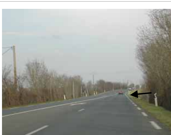
La conjonction des délinéateurs et de l'accotement étroit masque la lisibilité de l'intersection
