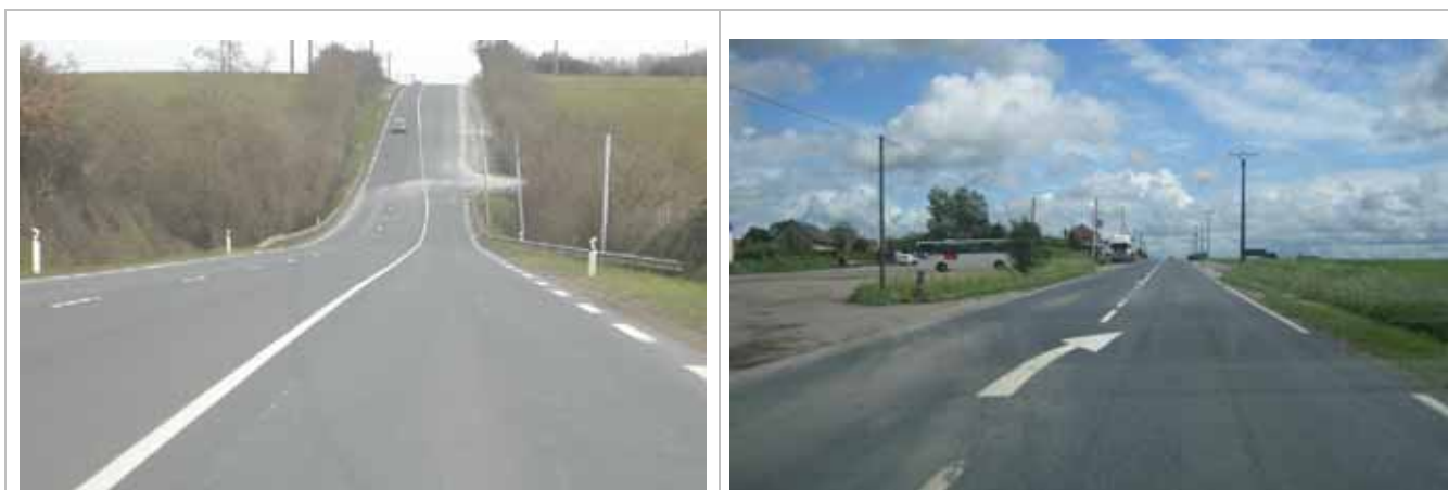
Photo de gauche : accès à une carrière ; Photo de droite : accès à un parking de restaurant
