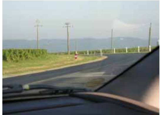
Exemples perte de profil (distance de visibilité faible) en milieu urbain (en haut d'une côte) et en interurbain (en virage)
