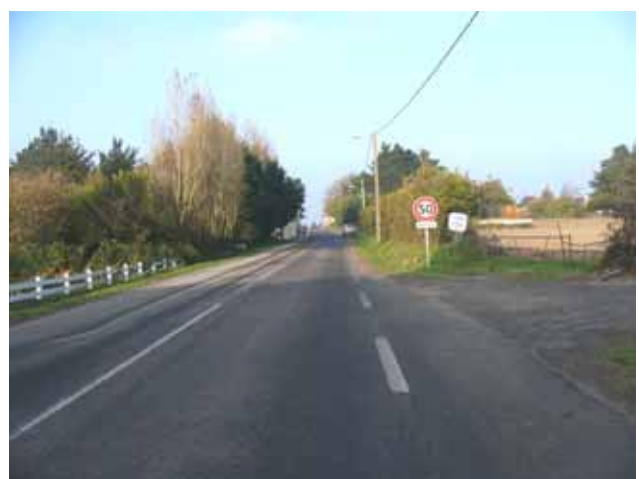
Le conducteur arrive en entrée de ville sans pour autant percevoir un changement de configuration de son itinéraire. L'information lui parvient uniquement par un panneau de signalisation
