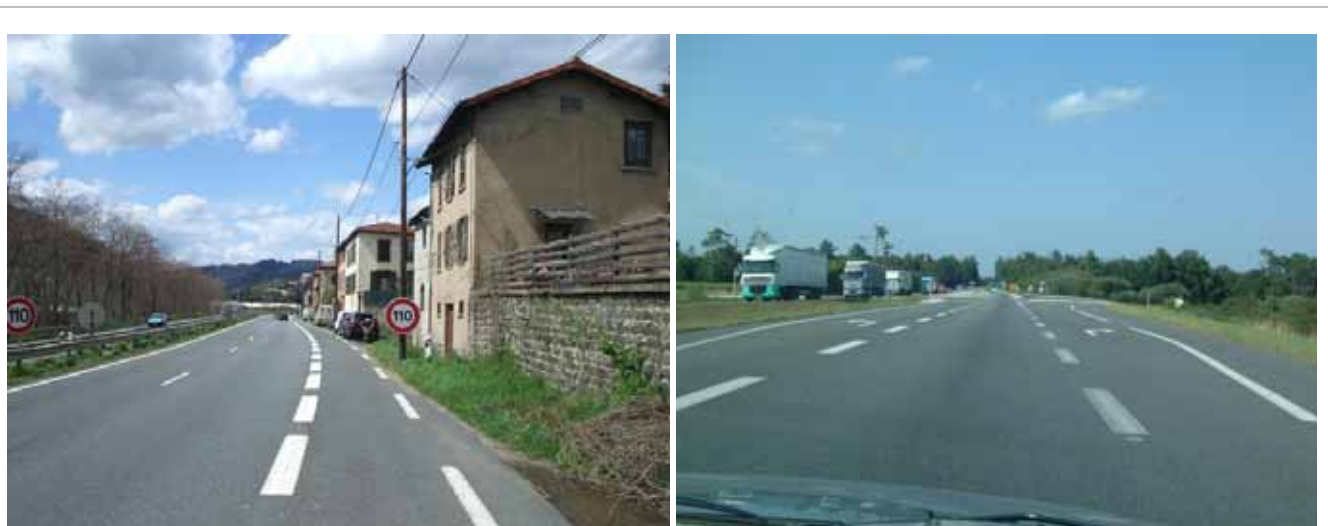
Exemples de décalage entre la fonction de la voie et la signalisation - Photo de gauche : limitation à 110km/h, bande cyclable, vie locale / Photo de droite : carrefour plans avec voie TAG et TAD (traversée du carrefour longue et dangereuse)
