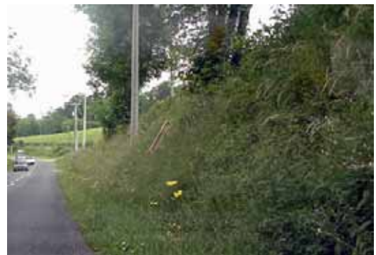
Exemple : réduction problématique des distances de visibilité en fonction du positionnement des panneaux de signalisation (à gauche) et du non entretien des accotements (à droite)
