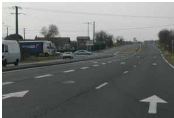
Malgré l'aménagement de carrefour (marquage au sol, îlots centraux, etc.), l'utilisateur du réseau secondaire aura des difficultés pour s'intégrer dans le flux de l'axe principal ou pour traverser
