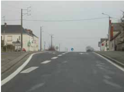
Exemples perte de profil (distance de visibilité faible) en milieu urbain (en haut d'une côte) et en interurbain (en virage)
