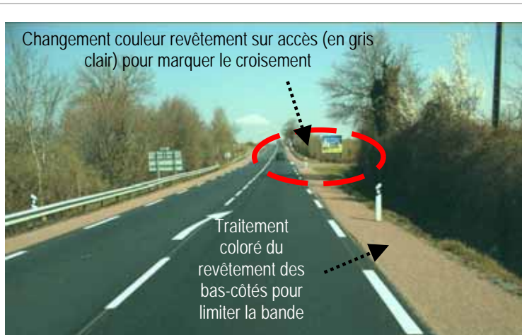
La différence de traitement de sol de l'accotement renforce la lisibilité de l'intersection
