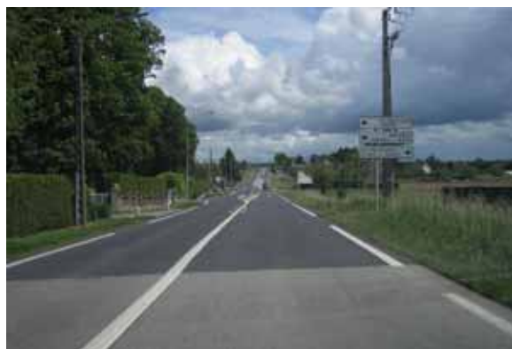
Malgré l'aménagement de carrefour (marquage au sol, îlots centraux, etc.), l'utilisateur du réseau secondaire aura des difficultés pour s'intégrer dans le flux de l'axe principal ou pour traverser
