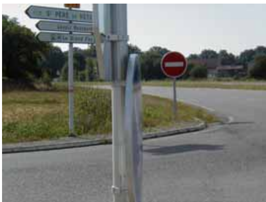
Exemple : réduction problématique des distances de visibilité en fonction du positionnement des panneaux de signalisation (à gauche) et du non entretien des accotements (à droite)
