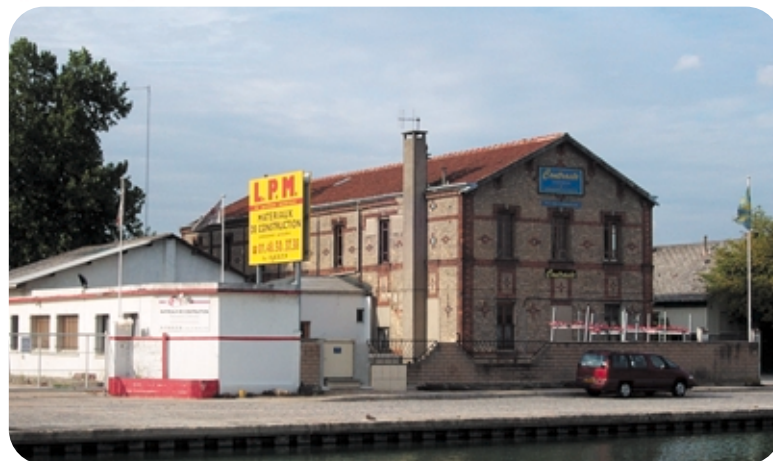
Photo prise sur le site prévu pour le futur emplacement de l'évacuation des déblais.
