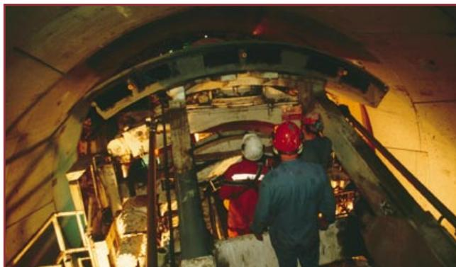
Mise en place d'un voussoir. La structure du tunnel est composée d'éléments béton préfabriqués (voussoirs) mis en place par le tunnelier pour former un anneau. Il faut généralement 8 voussoirs pour former un anneau complet (voir p. 59).
