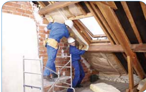
Travaux d'isolation dans un logement menés par des artisans locaux
