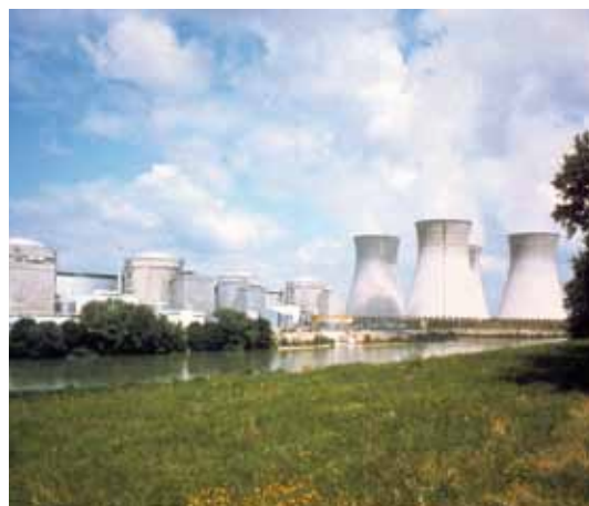
Centre nucléaire de production d'électricité du Bugey.
