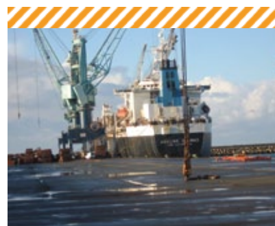
Port de La Pallice à La Rochelle (17) où des résidus de production (déchets de type TFA) de l'usine Solvay (ex-Rhodia) ont été utilisés comme remblai du port.
