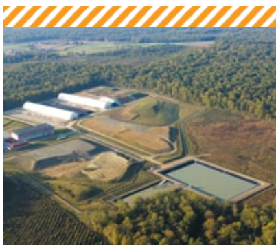
Centre de stockage pour les déchets TFA (de très faible activité) implanté sur le centre industriel de regroupement, d'entreposage et de stockage (Cires) dans l'Aube.
