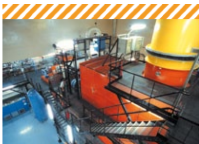
Le four d'incinération de Centraco.
