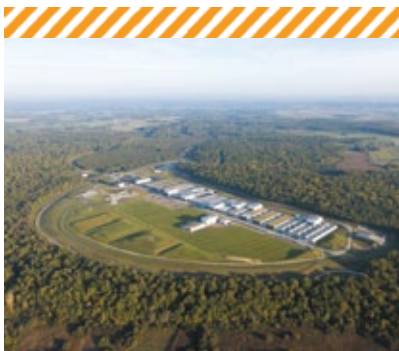
Centre de stockage de surface pour les déchets FMA (de faible et moyenne activité) situé à Soulaines-Dhuys (dans l'Aube).
