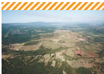
Ancien site minier de Tréviels après son réaménagement.
