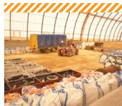
Mise en place de déchets TFA dans une alvéole de stockage, creusée à quelques mètres de profondeur dans une roche argileuse.
