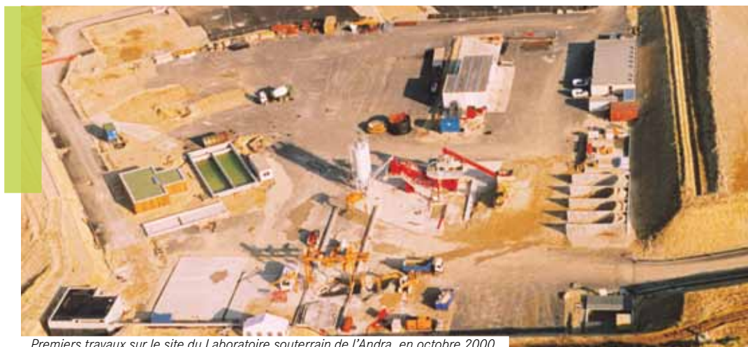
Premiers travaux sur le site du Laboratoire souterrain de l'Andra, en octobre 2000.
