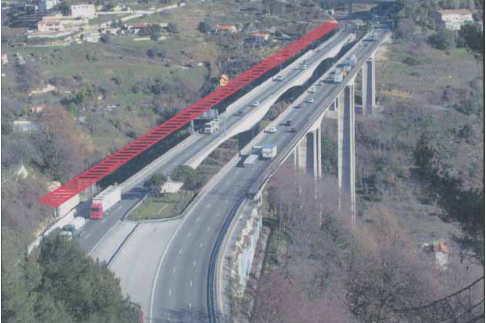
Viaduc de Magnan
