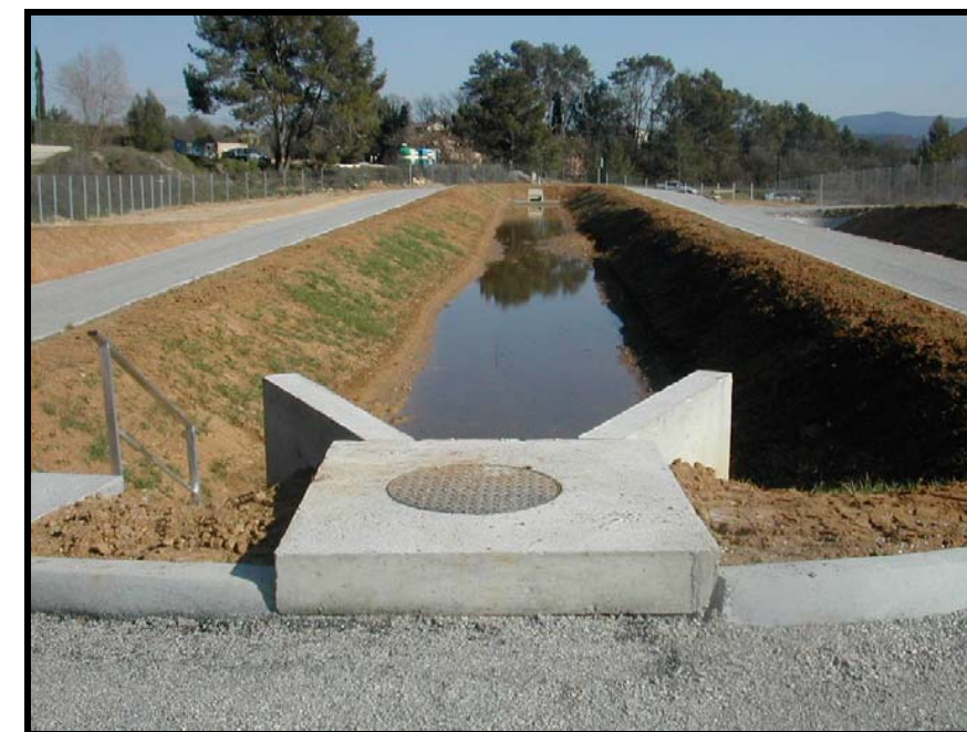
Exemple de bassin multifonctions pour le traitement des eaux en phase exploitation (Autoroute A8 section Brignoles – Le Cannet-des-Maures, Photo Scetauroute. F. BARRERE, 2004)
