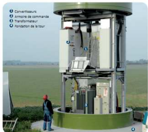
Figure 2 : Schéma des principaux composants électroniques dans le mât d'une éolienne (source : SER-FEE)
